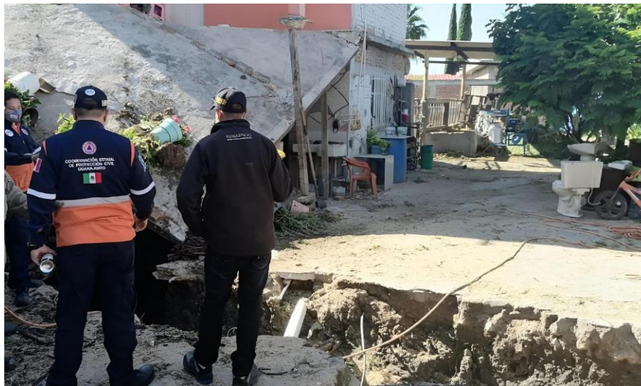
Figura 35. Afectación estructural a vivienda expuesta a agrietamientos y hundimientos diferenciales en el Estado de Guanajuato.
