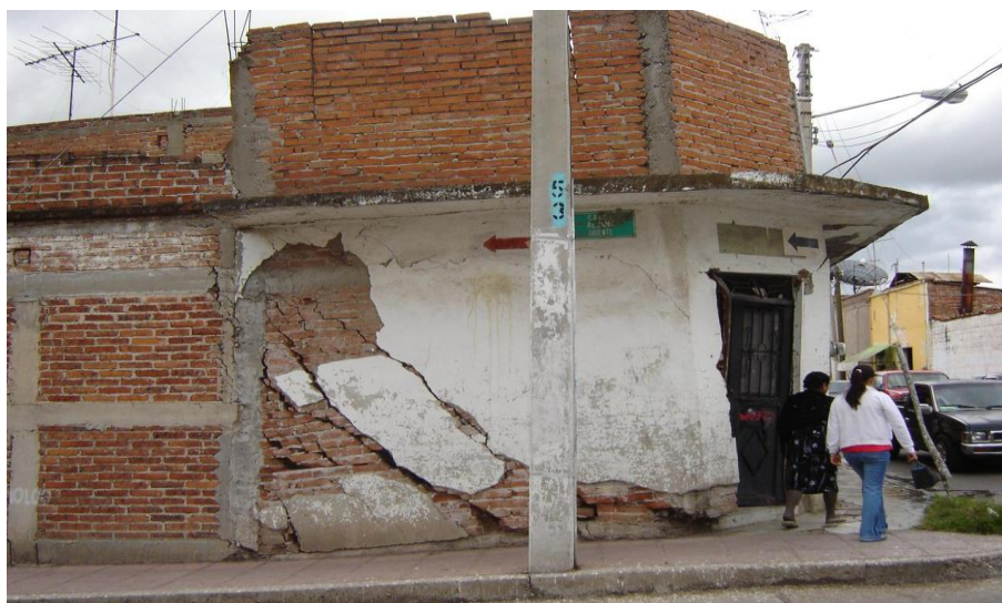
Figura 36. Vivienda expuesta a agrietamiento y subsidencia diferencial en el Estado de Guanajuato.
