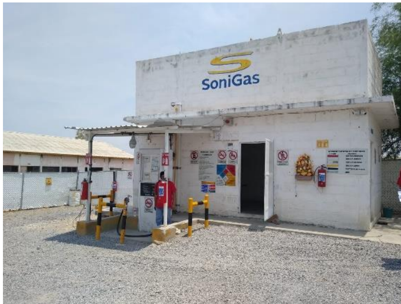
Figura 86. Estación de Gas L.P. para Carburación ubicada en el municipio de Apaseo el Alto. Fuente: (CEPC)
