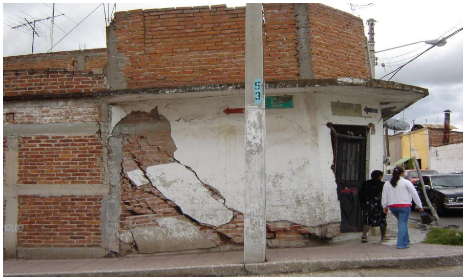
Figura 35. Vivienda expuesta a agrietamiento y subsidencia diferencial en el Estado de Guanajuato.
