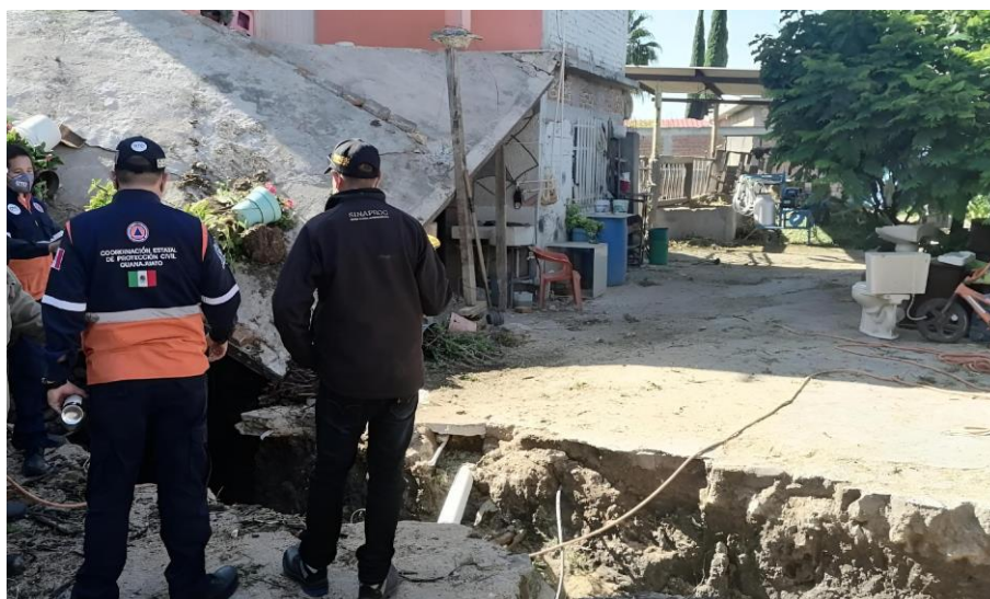
Figura 34. Afectación estructural a vivienda expuesta a agrietamientos y hundimientos diferenciales en el Estado de Guanajuato.
