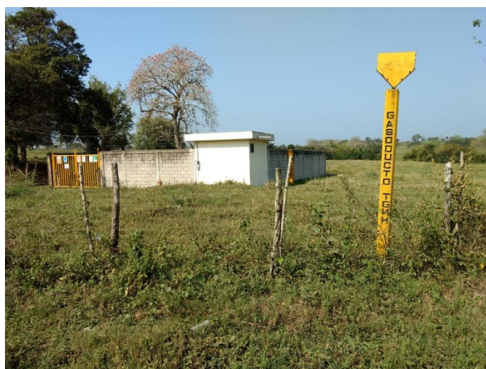
Esta imagen muestra el poste de gasoducto cercano a la Localidad la Ejido Canoas. Coordenadas UTM 14Q, 605413.49 E – 2367025.19 E; atraviesa el municipio de este a oeste (AGYD GROUP, 2018).
