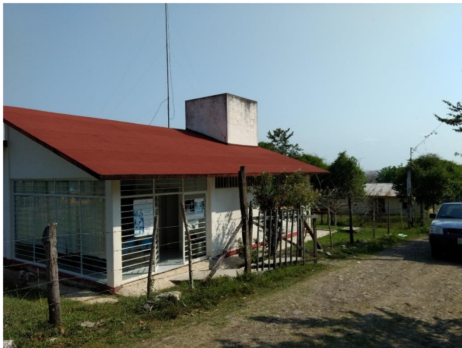
Clínica de Salud de la Localidad de Ejido Canoas, coordenadas 14Q, 604917.99 E – 2367618.49 N (AGYD GROUP, 2018).
