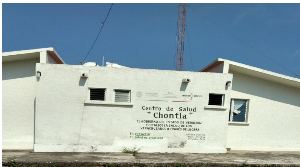
Centro de Salud en la Cabecera Municipal, coordenadas 14Q 611746.41 E – 2354894.29 N (AGYD GROUP, 2018).
