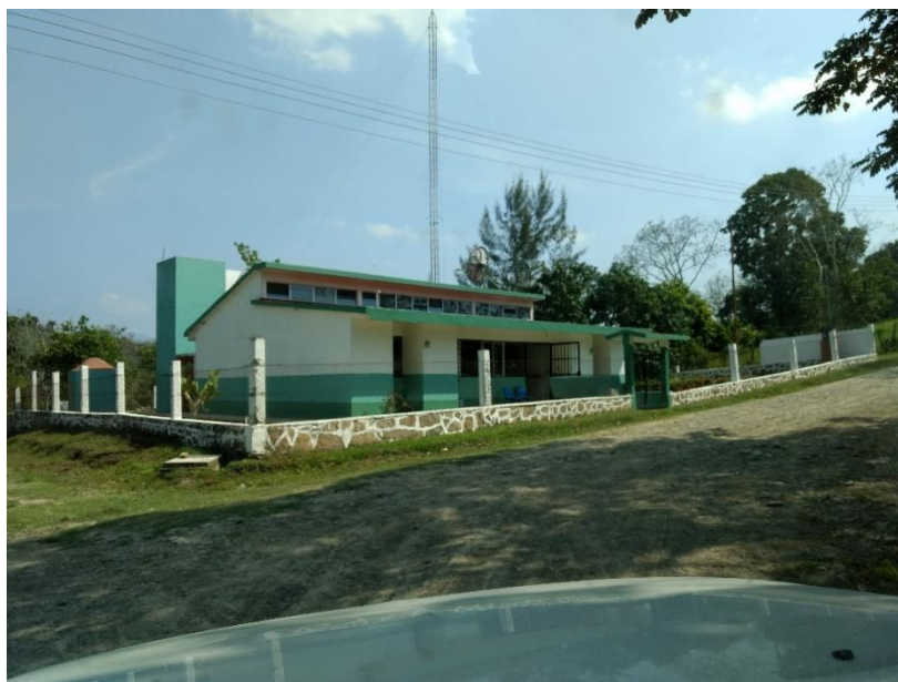
Clínica IMSS PROSPERA, unidad médica ubicada en Localidad Mata de Ote, coordenadas 14Q, 605408.43 E – 2361028.44 N (AGYD GROUP, 2018).
