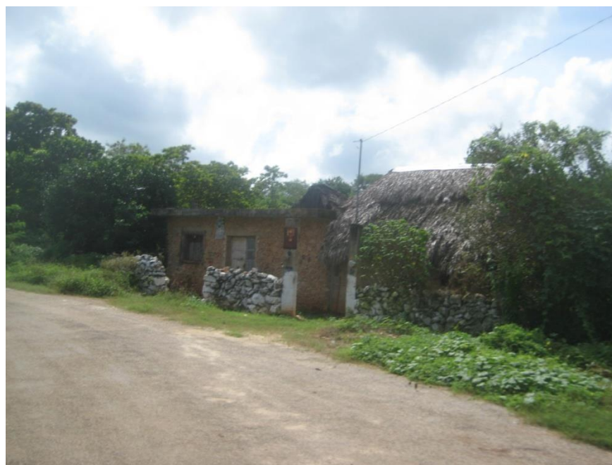
FOTO 3. VIVIENDA EN ZONA DE INUNDACIÓN EN LA COLONIA BENITO JUAREZ.
