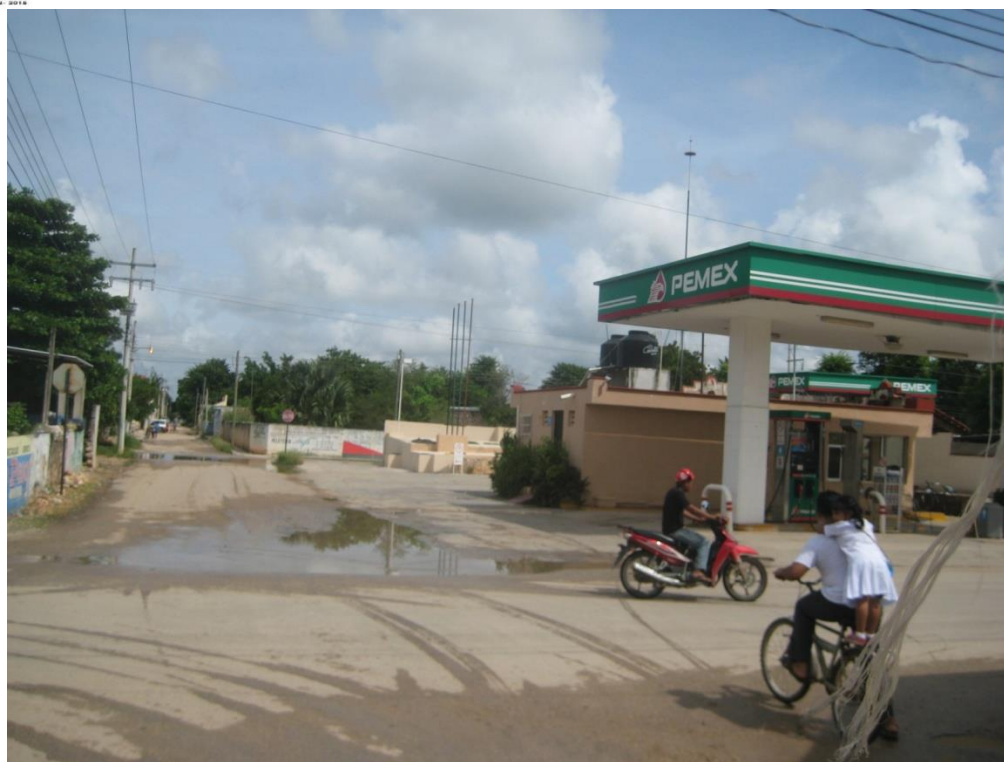
FOTO 10. ZONA DE INUNDACIÓN CALLE 23 X 40
