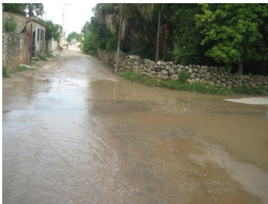
FOTO 11. CALLE 40 ZONA DE INUNDACIÓN
