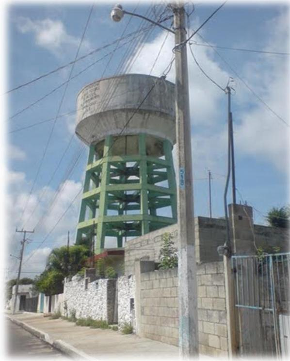
Imagen 29. Depósito Elevado de Agua Potable
