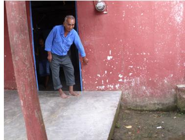
Figura 105. Marca de Profundidad de Inundación (0.40 mts.) en la parte más afectada de la Población José María Morelos y Pavón 2ª Sección “Ejido El Limón”.
