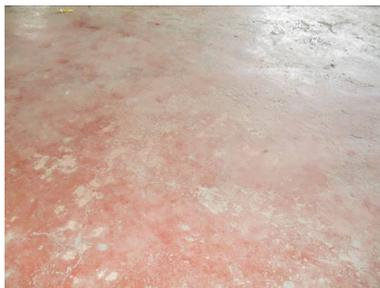
• **El piso del Salón** está en mal estado ya que presenta fracturas en toda su superficie. [Figura 95.](#)
