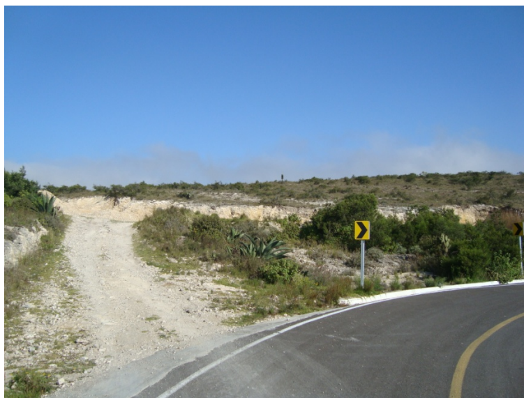
Figura RG-10.- Inicio de procesos de erosión por falta de cubierta vegetal y trazo de caminos
