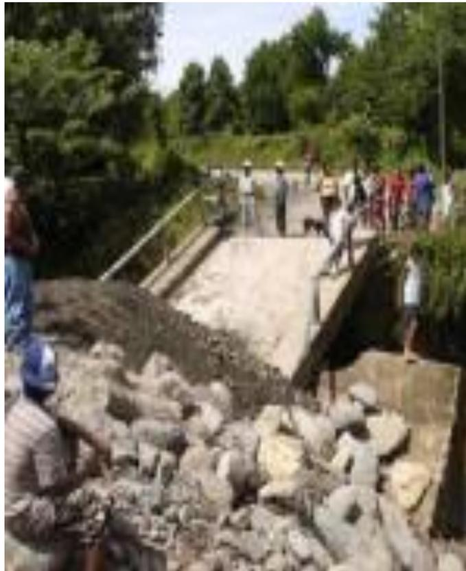
*Fotografía 1.2. Destrucción de un puente en el municipio de Pijijiapan, ocasionadas por el huracán Stan.*
