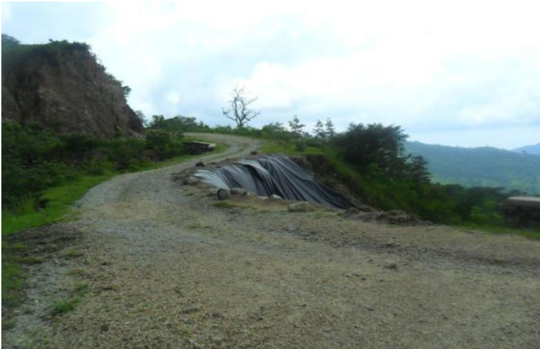
Foto 6.6.24 Se observa el derrumbe de uno de los tramos de carretera, en el acceso al poblado El Rosario.
