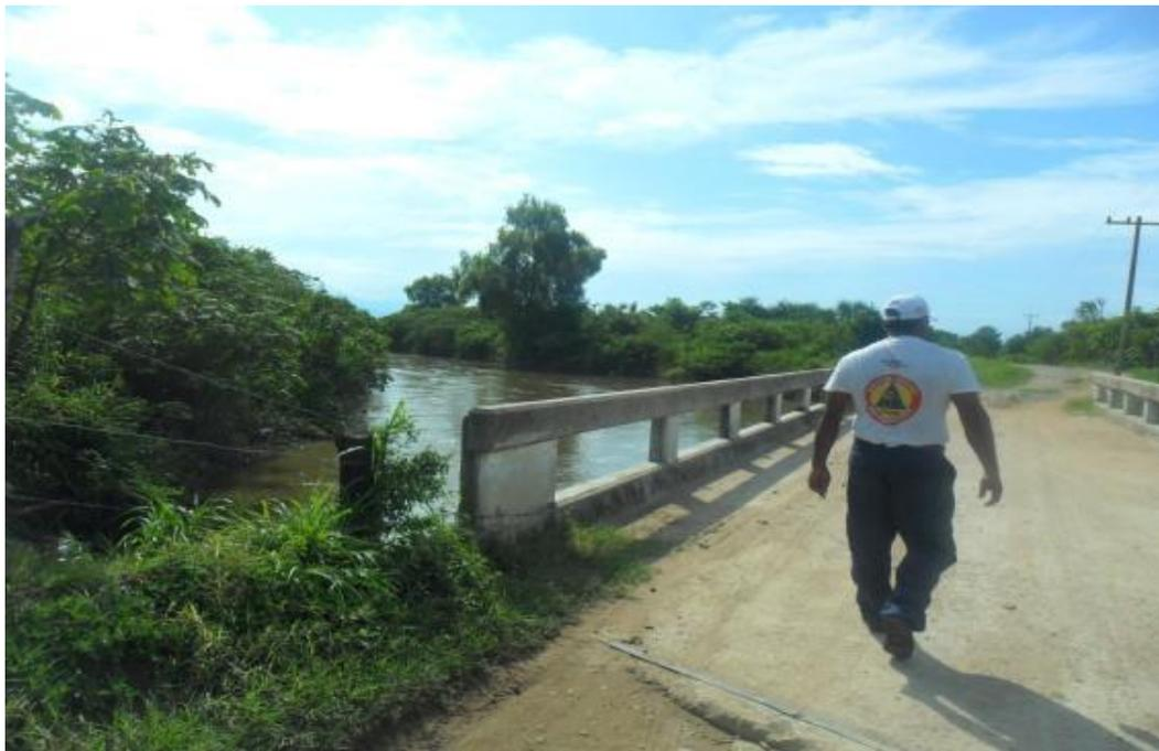
Foto 6.6.28 Río San Diego, se aprecia el punto de por donde el río socava la base del puente, en las inmediaciones de Santa Virginia.
