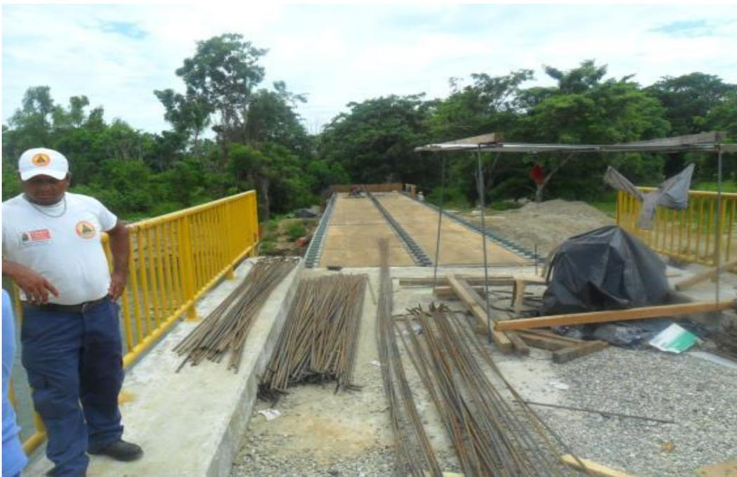
Foto 6.6.34 Se muestra la construcción de la losa del puente sobre el río Pijijiapan, cercano al poblado El Amatal.
