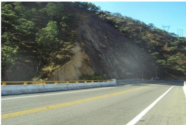
Foto No.11. Sitio de derrumbe con material no consolidado.
