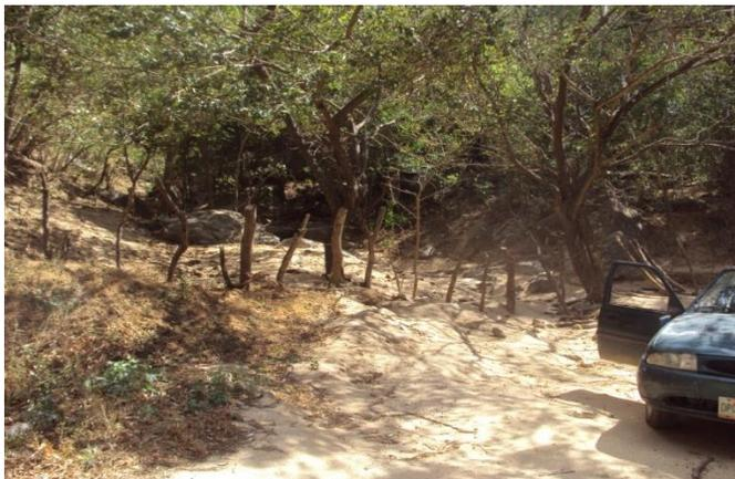
Foto No.38. En la imagen se observa que el escurrimiento arrastra y deposita materiales pétreos sobre el camino.
