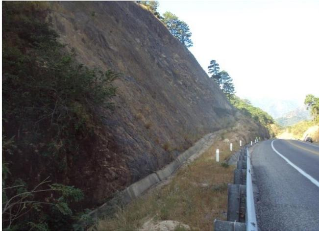
Foto No.9. Vista lateral del sitio de derrumbe, donde se observa un canal de desagüe pluvial
