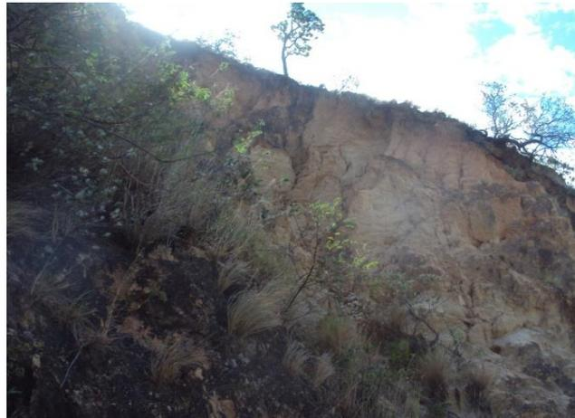
Foto No.35. El derrumbe de piedras hacia la carretera es patente en algunas cárcavas
