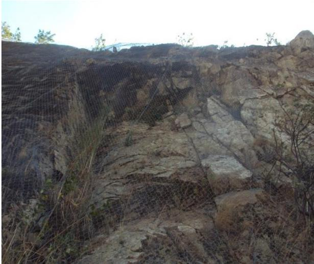
Foto No. 18. Vista frontal del sitio de derrumbe, donde se puede apreciar la importancia de la colocación de la malla de contención.
