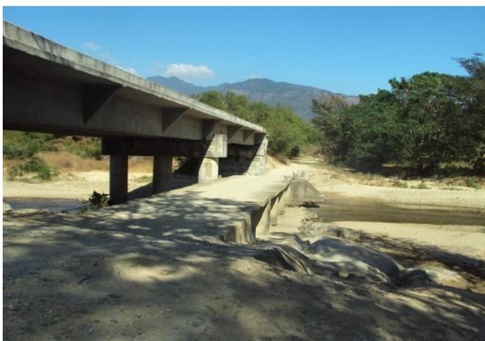
Foto No.114. Puente inconcluso y puente alterno en el tramo Lázaro Cárdenas-Nuevo Progreso
