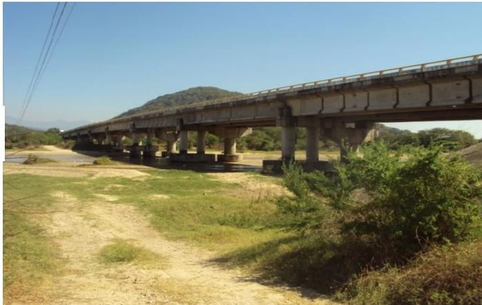
Foto No.154. Se puede apreciar que la cimentación del puente está siendo erosionada por las corrientes de agua
