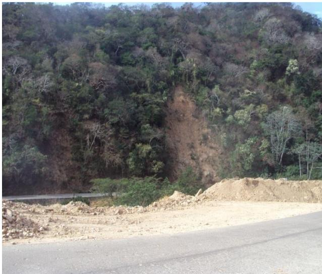
Foto No.27. Punto de derrumbe incipiente, donde debido a la desestabilización inicial puede continuar aún con la presencia de vegetación.
