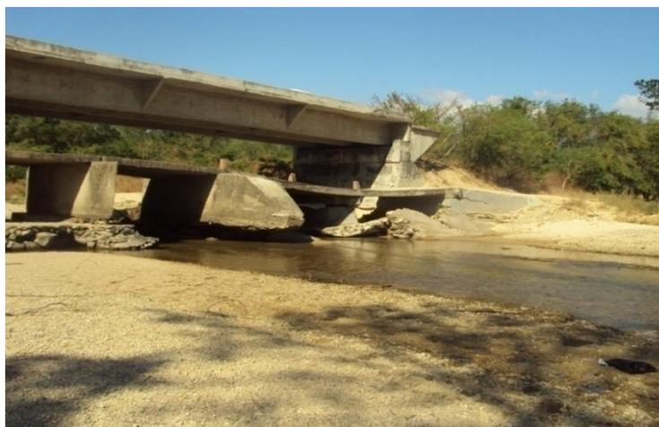
Foto No.116. Detalle del puente alterno que presenta peligro de derrumbe
