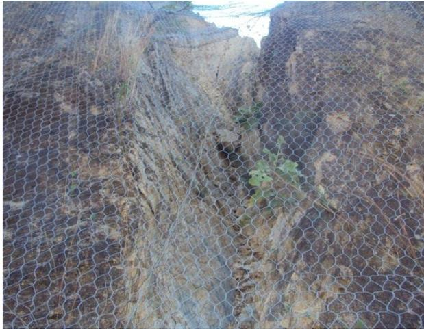
Foto No.16. Sitio de derrumbe en donde se observa que el material está a punto de caer.
