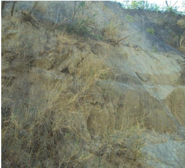
Foto No.20. Vista frontal del derrumbe, donde existen algunos materiales relativamente sueltos.
