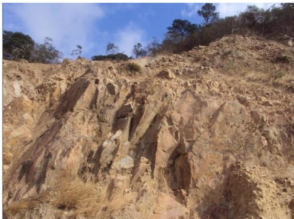
Foto No. 25. El sitio de derrumbe no cuenta con malla de protección.
