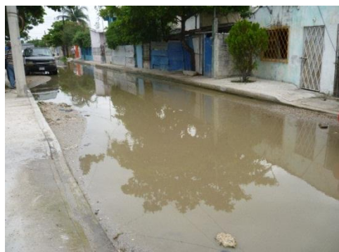
Foto 3. Calle Francisco Villa con Constitución
