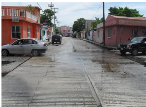
Foto 25. Calle 41 entre 40 y 38
