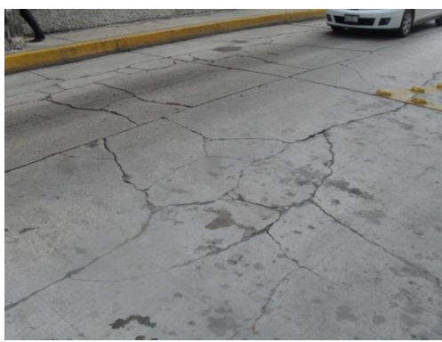
Foto 20. Calle 31 por calle 28, Col. Centro.
