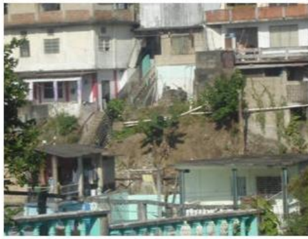
i. Viviendas sobre laderas naturales
