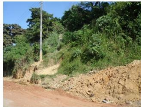
v. Construcción de caminos
