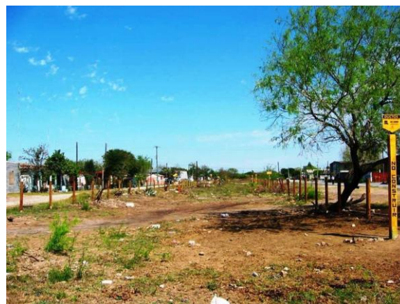
Fotografía 57. Ductos de Pemex en las calles Primera y Solidaridad - colonia Ejido La Unión (DUC5002).
