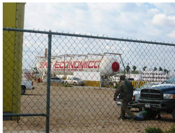
Fotografía 39. Tanque de almacenamiento de 200 mil litros de Gas Económico de Matamoros (GAS5006).
