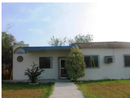
Unidad Rehabilitación (DIF5019), Valle H.
