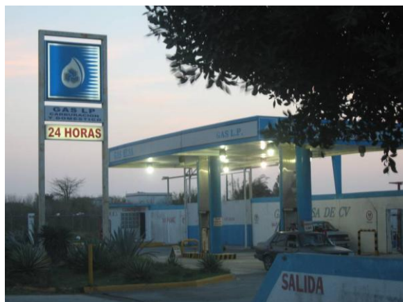
Fotografía 43. Gas Elsa S.A. de C.V. (GAS7002).
