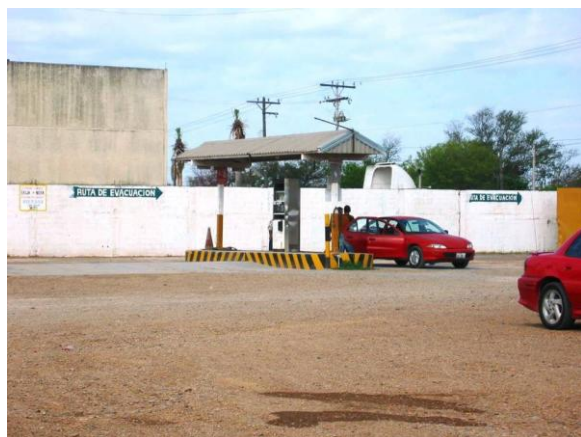
Fotografía 38. Gas Económico de Matamoros S.A. de C.V. (GAS5006), ubicado en la colonia Villa Norte.
