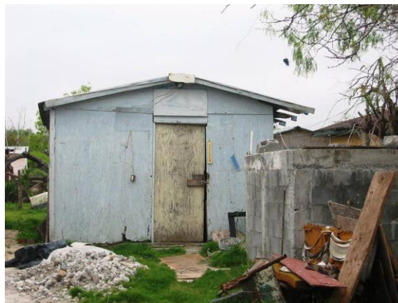
Fotografía 59. Viviendas tipo 1 cerca de ductos, en la colonia Ejido La Rosita.
