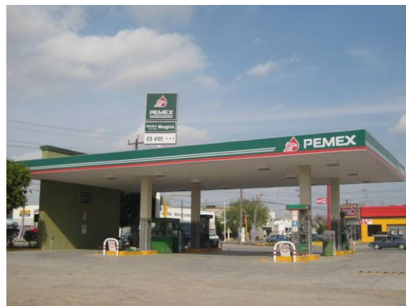
Fotografía 52. Vista frontal de Gasolinera Energéticos Valle Hermoso No. 4158 (GSO4303).
