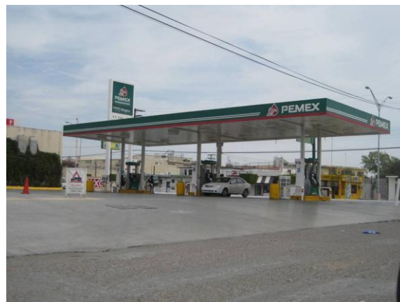
Fotografía 47. Tanques de almacenamiento ubicado gasolinera Autoservicio Matamoros No. 2081 (GSO8005).
