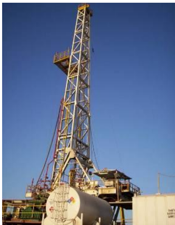
Fotografía 54. Pozo de exploración de gas ubicado al norte de la ciudad de Valle Hermoso.
