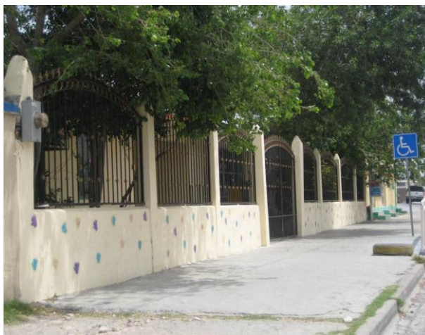
Fotografía 34. Escuela Ixtaxochitl ubicada en la colonia Industrial en peligro por la gasolinera Autoservicio Matamoros
