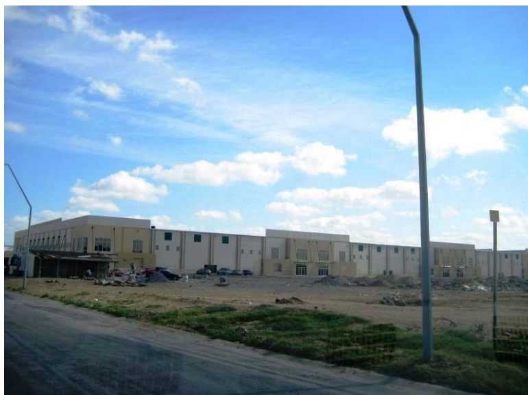
Fotografía 26. Conclusión de construcción en el Parque Industrial Oradel.
