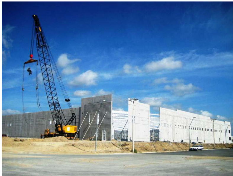
Fotografía 25. Construcción de nueva nave en el Parque Industrial Oradel.
