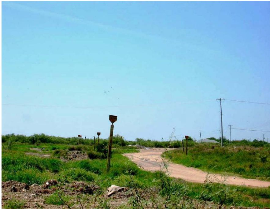
Fotografía 15. Trazo de ductos de gas ubicados paralelos a caminos y accesos a la Ciudad.
