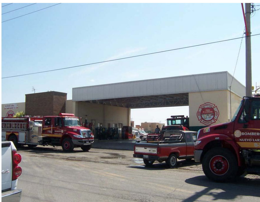
Fotografía 11. Estación de Bomberos No. 5, en Fraccionamiento Vista Hermosa. (BOM6018).
