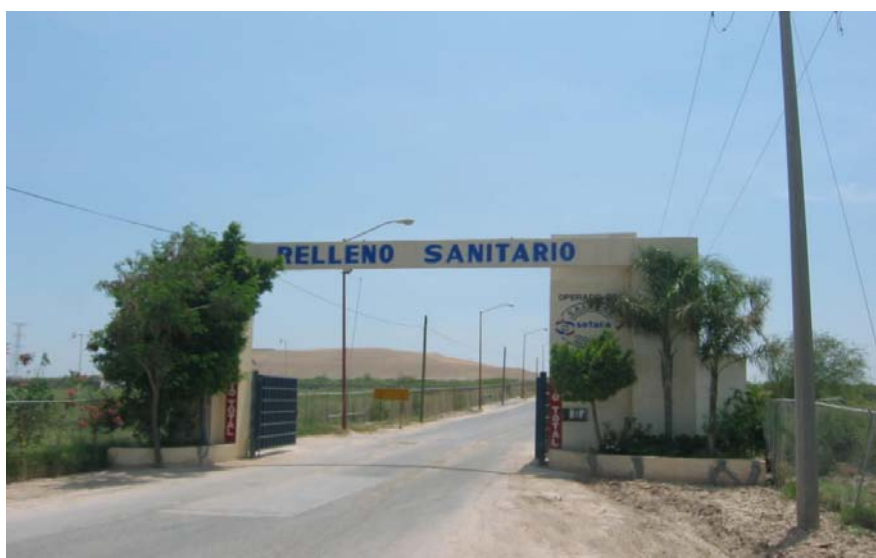
Fotografía 36. Relleno Sanitario de Nuevo Laredo.
