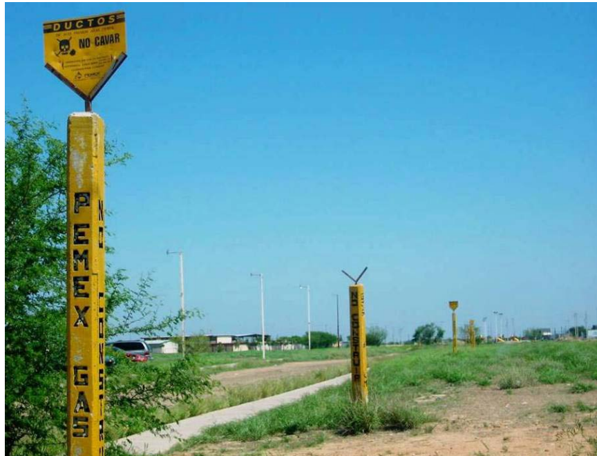
Fotografía 16. Trazo de ductos de gas paralelos a la calle Prometeo en la colonia Fraccionamiento Progreso (Reservas Territoriales), de la Ciudad de Nuevo Laredo.
