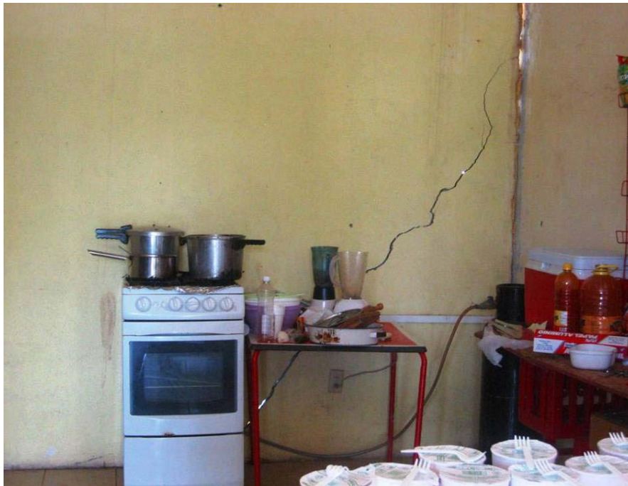
Fotografía 13. Fractura sobre el muro de la escuela Profesora María De la Fuente Zertuche (ESC5267).
