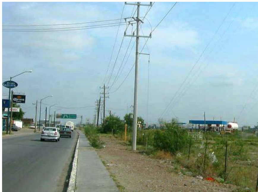
Fotografía 17. Ductos de gas en la colonia Bertha del Avellano.
